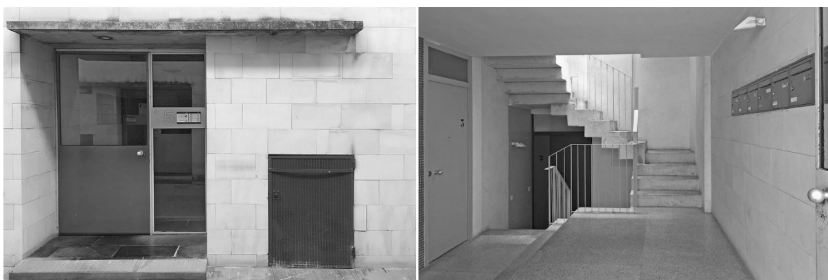
Figura 7: Portal de acceso al nº 5 de la calle Cova Santa. Escalera en turbina vista desde el zaguán.
