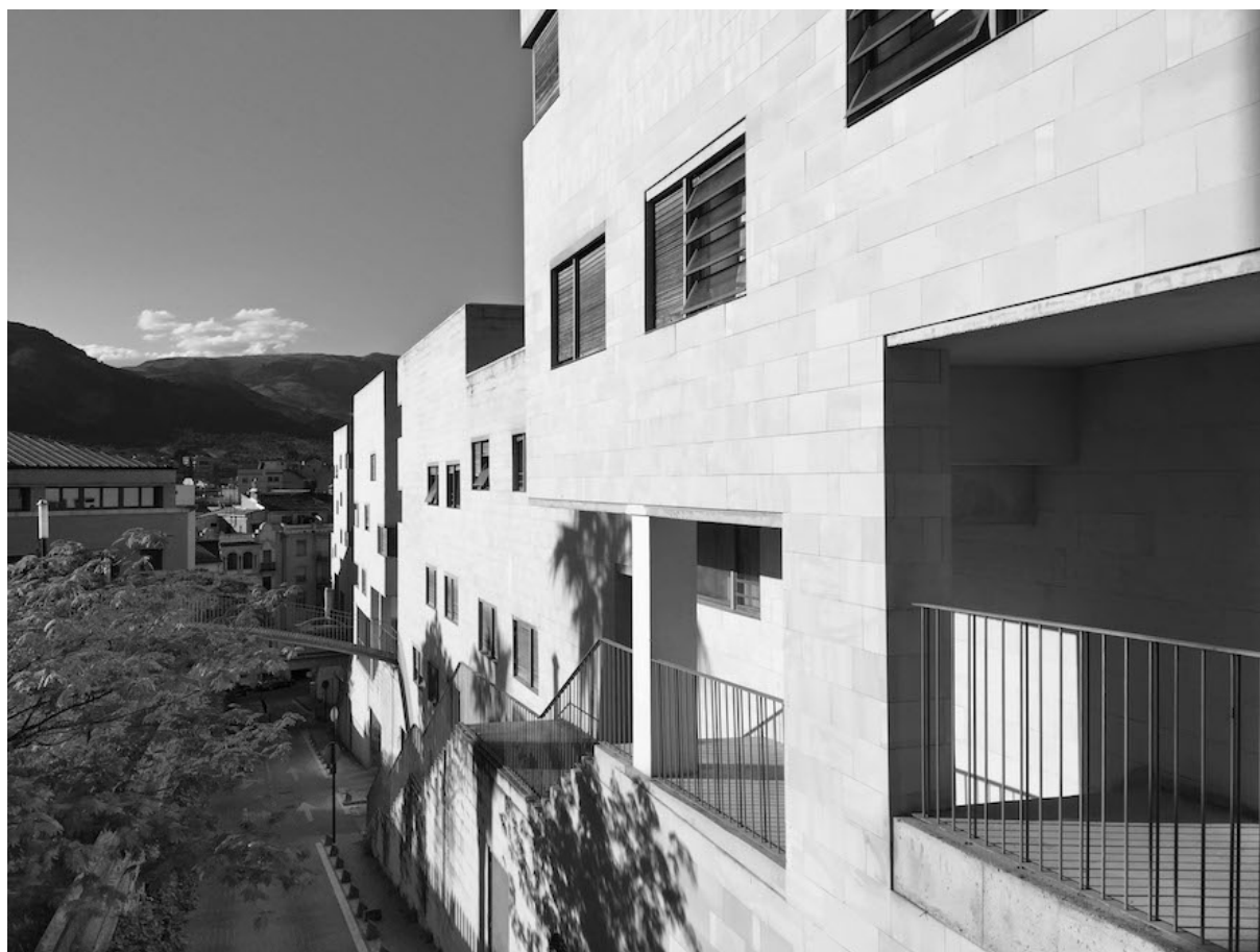
Figura 14: Rampa de la Sang vista de la calle Cova Santa.
