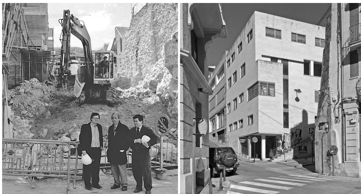
Figura 13: Los arquitectos Juan Lorenzo, Manuel de Solà-Morales y Vicente Vidal Vidal durante la apertura de la rampa de la Sang. Vista del edificio de la calle Gurugú desde el que arranca la rampa de la Sang.
