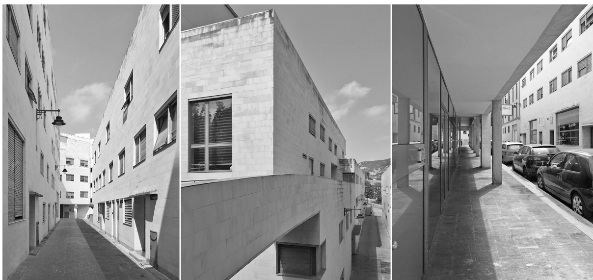
Figura 6: Calle Cova Santa, calle Sang con pasarela sobre calle San Mateo y acera de calle Sant Doménech.
