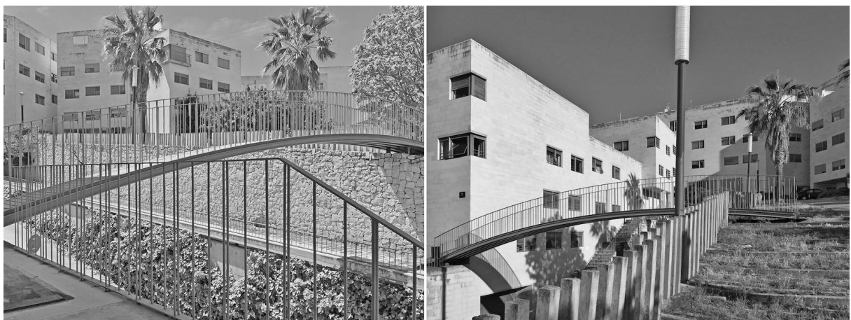
Figura 12: Acercamiento a la materialidad de los elementos que componen la rampa y el parque
