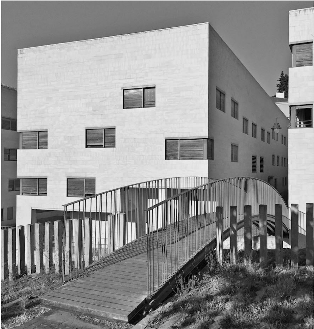
Figura 3: Vista de la pasarela peatonal que prolonga la calle Sang cruzando la rampa de la Sang.
